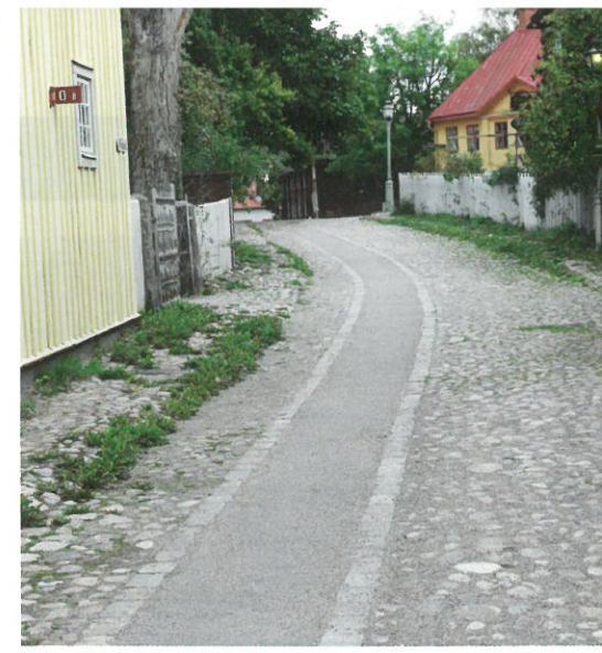
I Gamla Linköping har de gamla gatorna med gatsten i olika former försetts med särskilda gångstråk för att underlätta för rörelsehindrade och barnvagnar att ta sig fram.
